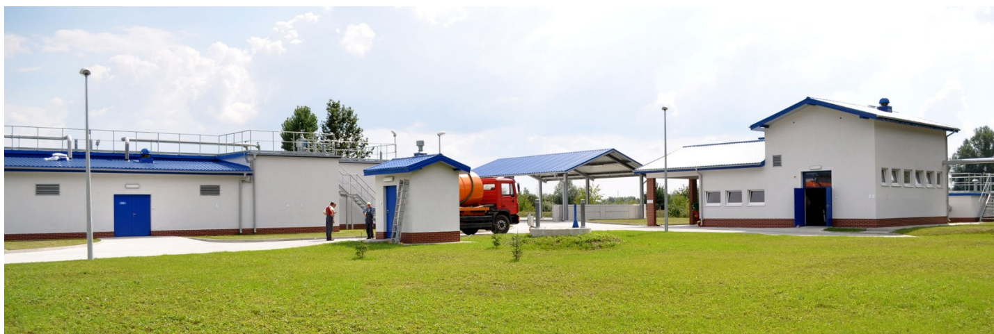
Od lewej – sekwencyjny reaktor biologiczny, punkt zlewny, plac składowania osadu, budynek z piaskownikiem i prasą osadu
