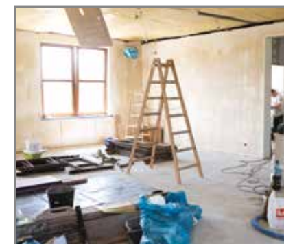
Trwa remont pomieszczenia w strażnicy OSP
