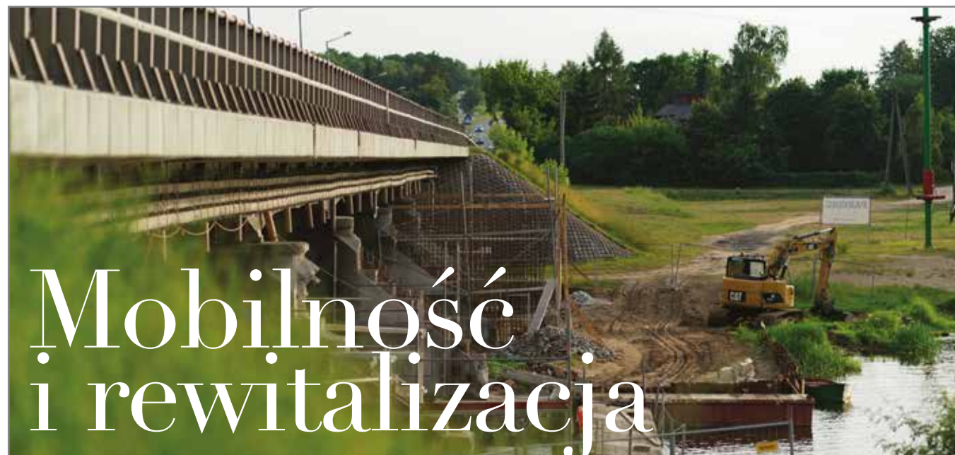
Budowa kładki przez rzekę, fot. Piotr Murawski
