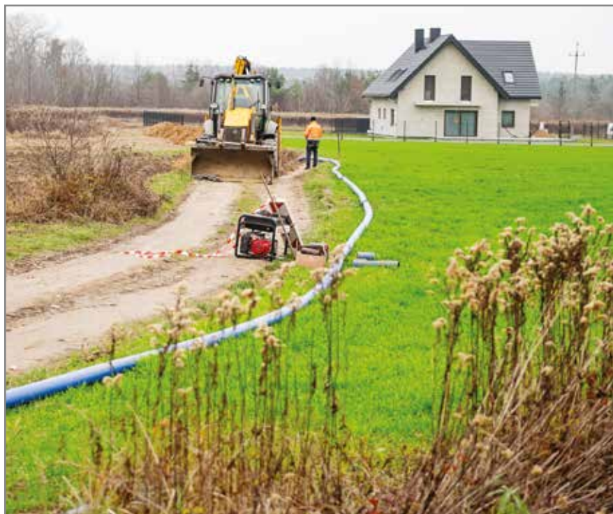
Spółka „Wkra” buduje infrastrukturę wodno-kanalizacyjną.
