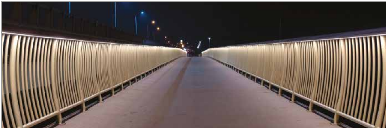
Widok kładki nocą
