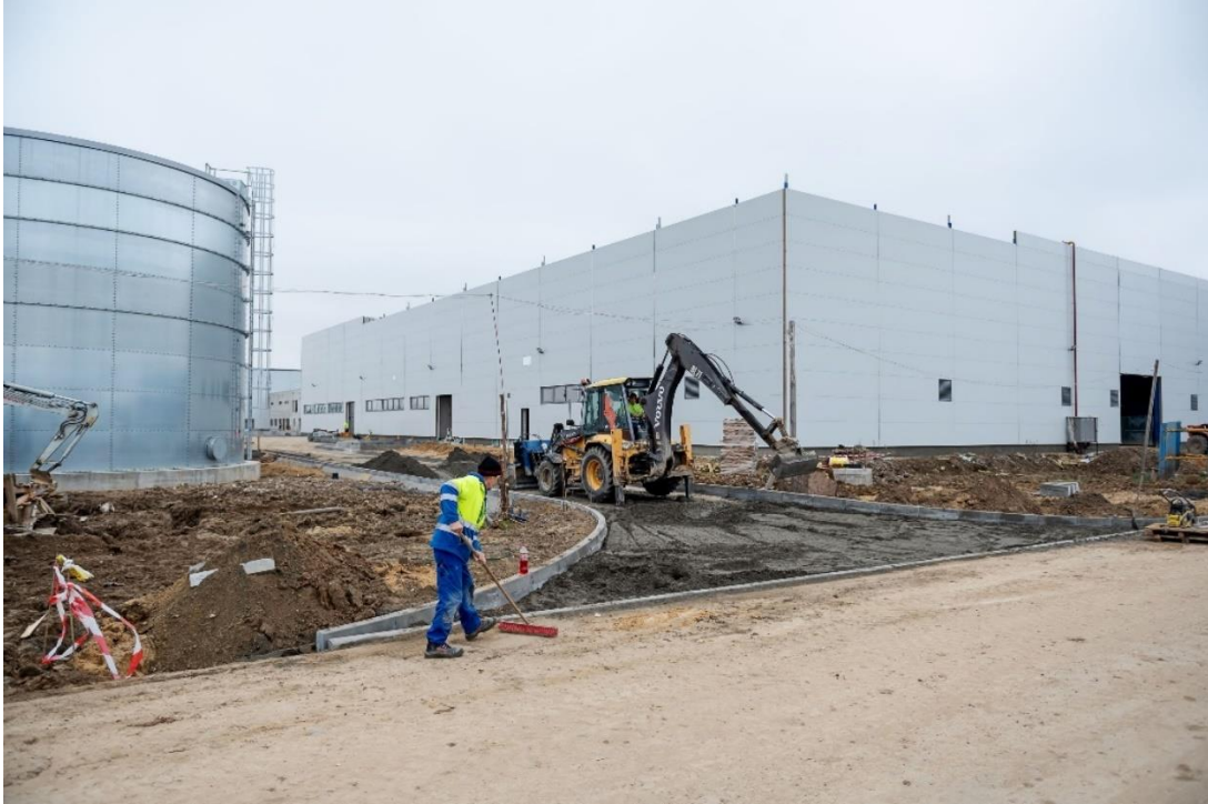
Rysunek 2 - budowa firmy EcoWhipes, grudzień 2022 r.
