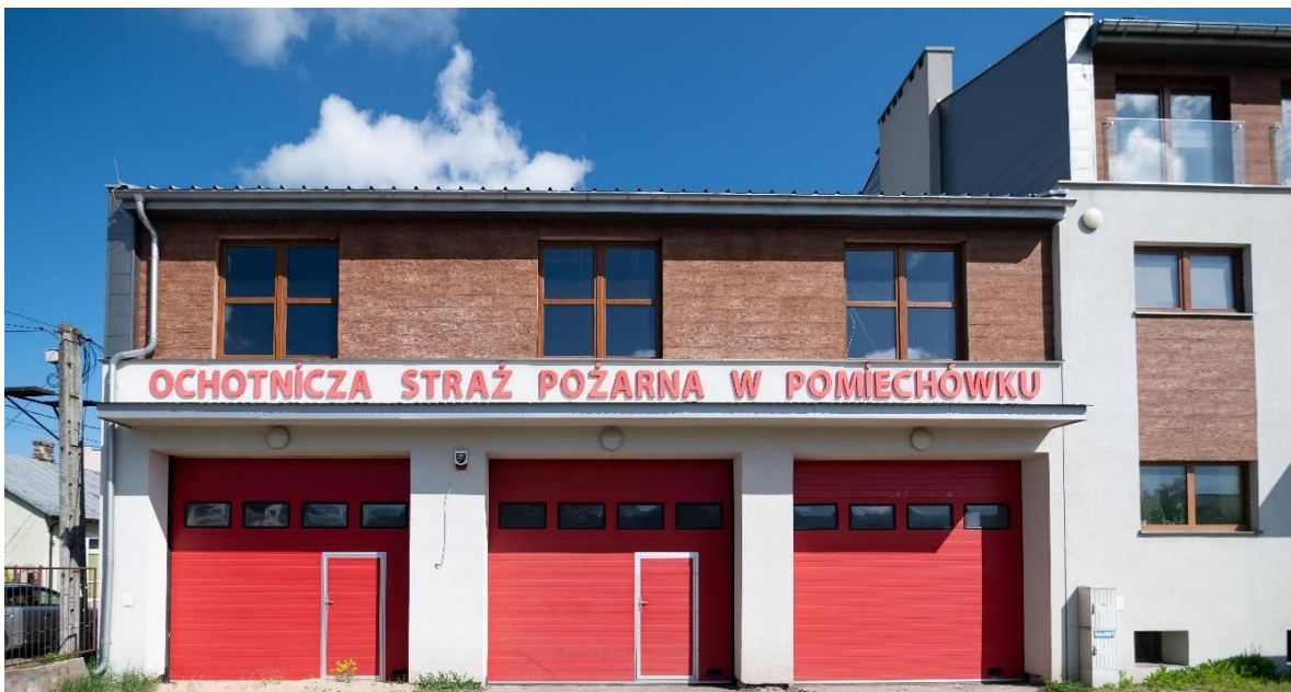
Rysunek 7 Budynek Ochotniczej Straży Pożarnej w Pomiechówku
