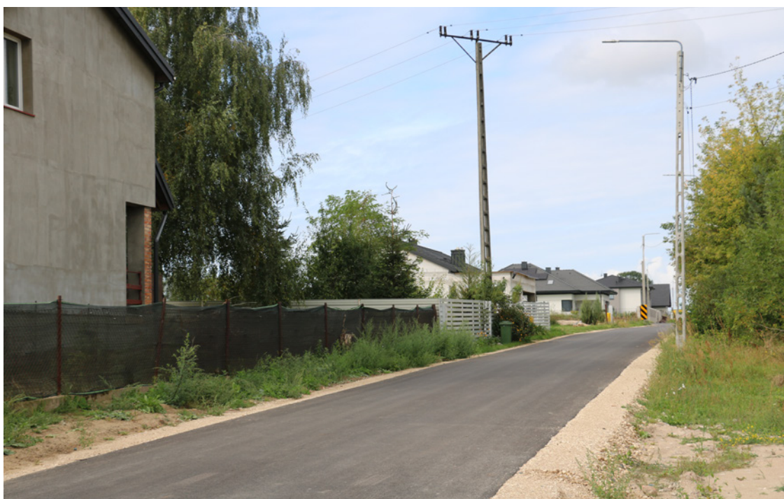
16. Przebudowana ul. Lotników w Pomiechówku.
