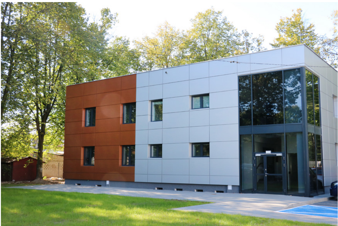
18. Nowy budynek urzędu gminy.
