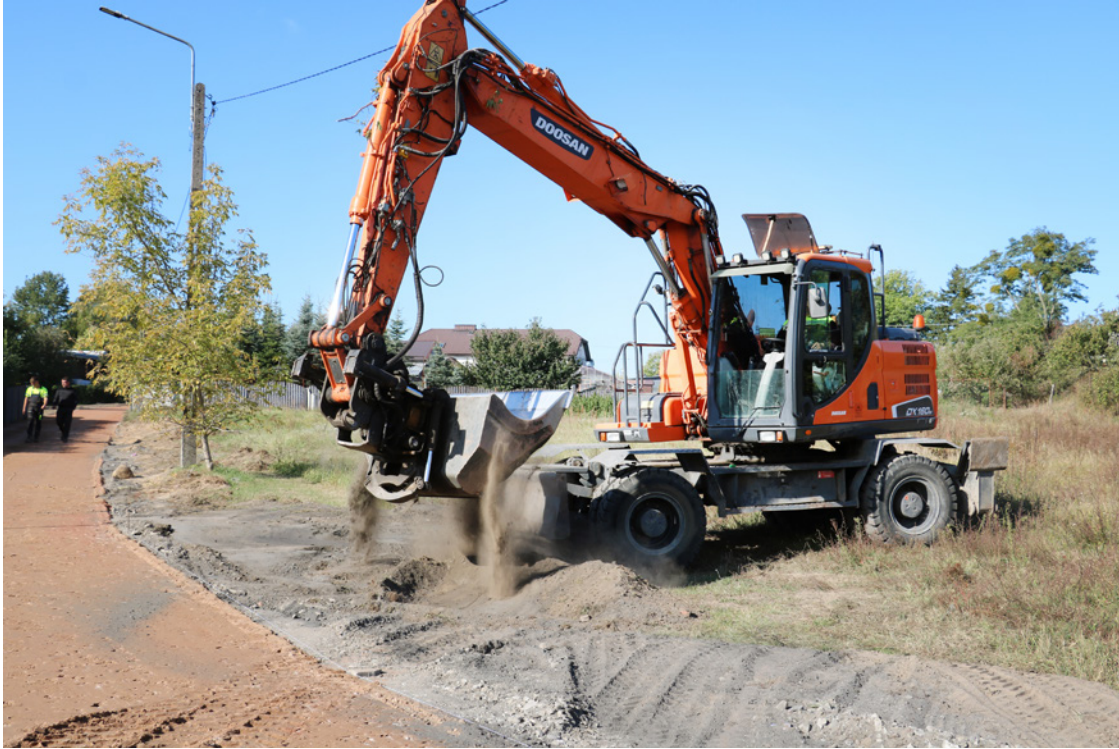
6. Przebudowa drogi w Stanisławowie.
